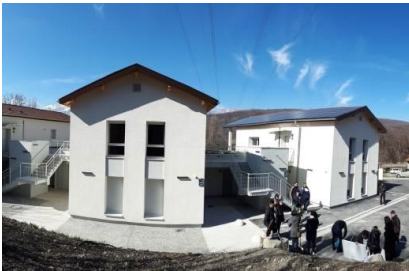
La résidence des Clares à Jarrie est le premier bâtiment privé à intégrer des panneaux solaires made in Energ'Y Citoyennes. © Alpes Isère Habitat
