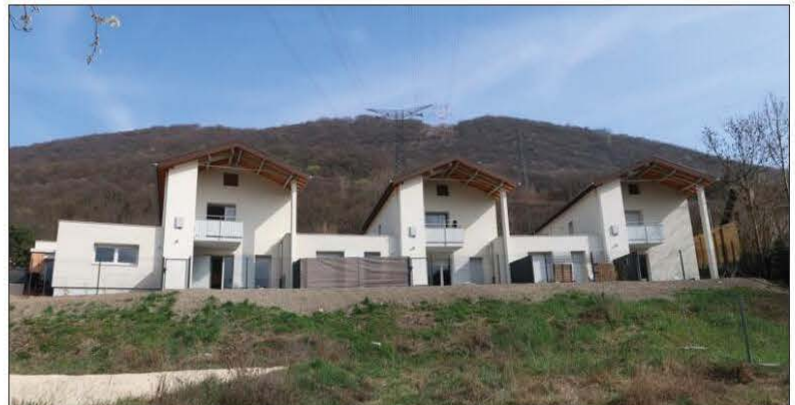
Composée de neuf logements sociaux du T2 au T4, la résidence est équipée de 180 m 2 de panneaux solaires financés par les citoyens (via Énerg'Y citoyennes). Photo Le DL/Ma.B.
